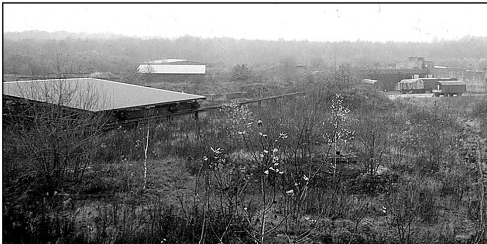
*Im Vordergrund links eine zurückgefahrne Tarndachanlage für eine Startrampe in der Feuerstellung der FRA-134. Das Zurückfahren bei Auslösung von B-1 nahm bei einsatzbereiten Tarndächern der Diensthabende des Gefechtsstandes oder der OSM mit Hilfe der Bedienungsapparatur im Gefechtsstand vor. Der Gefechtsstand ist rechts hinten im Bild erkennbar.*
